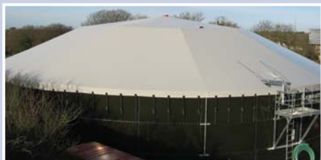
Cubiertas de PVC
